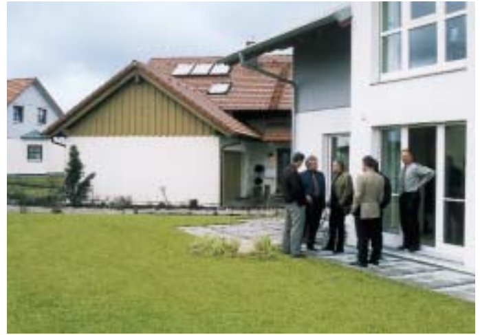
Musterhaus-Eigenheim-Siedlung im Bauzentrum Poing. Hier das OptiNorm® Niedrigst-Energiehaus mit Erdwärmeheizung. 140 m 2 Kollektorfläche sind unter der Rasenfläche in 1,20 m Tiefe „vergraben“
