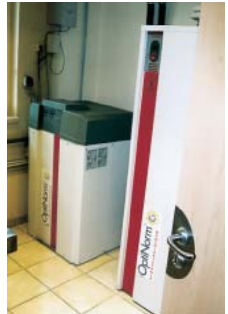
Das Herz der OptiNorm Erdwärmeheizung: Die Ochsner Wärmepumpen für Kältemittel-Direktexpansion und -Kondensation. Rechts die Brauchwasser-WP mit Wärmerückgewinnung
