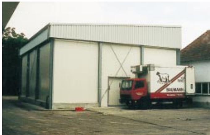
Das neu errichtete Kühlhaus der Lamm-schlachtereier Baumann dient der Zwischenlagerung, bevor das Fleisch an verschiedene Abnehmer weitergereicht wird
