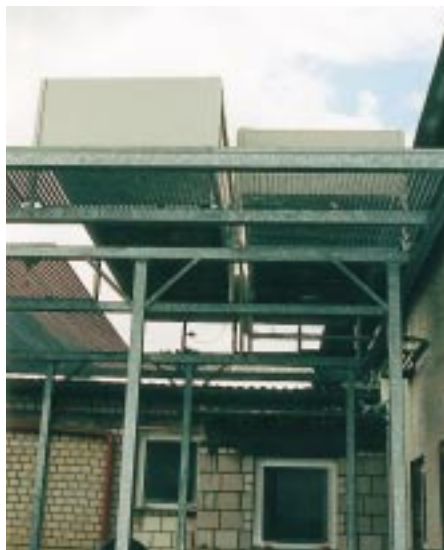
Die beiden Verflüssiger für den Plus- und Minusverbund wurden im Außenbereich auf einer speziellen Stahlkonstruktion aufgestellt
